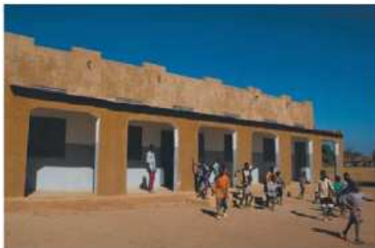
École construite grâce aux fonds de la prime Fairtrade, Mali
