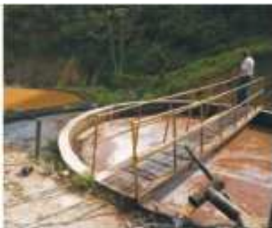
Installations de traitement de l'eau, Costa Rica
